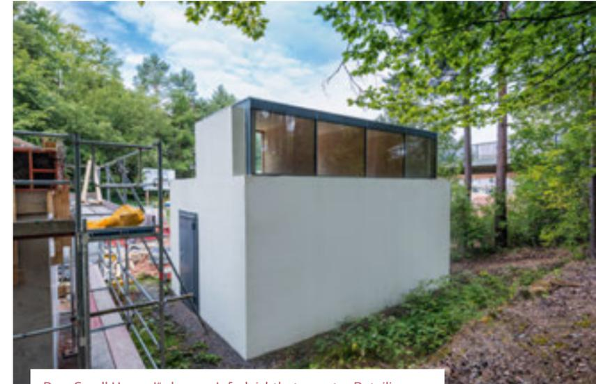
Das „Small House I“, das aus Infraleichtbeton unter Beteiligung der Heidelberger Beton GmbH errichtet wurde, steht bereits seit 2014.
