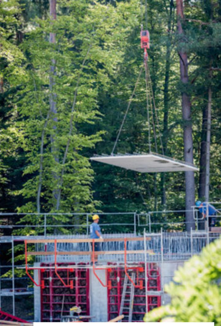
In dem Forschungsgebäude aus R-Beton mit verzinkter Stahlbetonbewehrung wird eine Klimakammer untergebracht, in der im Rahmen von Forschungsprojekten bauphysikalische Behaglichkeitsuntersuchungen durchgeführt werden. Einheben der Filigrandecken hergestellt von der Heidelberger Betonelemente GmbH & Co. KG
