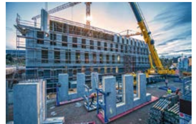
Produktion und Montage der Betonsandwichenelemente von der Firma Dressler aus Aschaffenburg. Für den Bau der Betonfertigteile kam der Schnellbeton Chronocrete X zum Einsatz – geliefert von der Heidelberger Beton Aschaffenburg GmbH & Co. KG.
