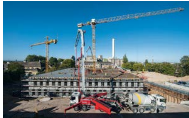
Die Fertigstellung des neuen Labor- und Bürogebäudes des HeidelbergCement Technology Centers wird im Spätsommer 2016 sein.
