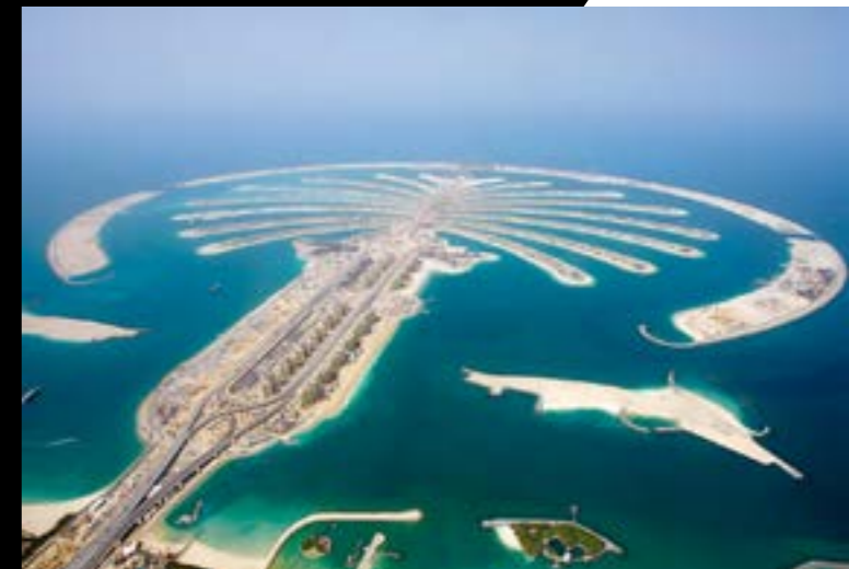
Oben: Über das neue NS-Dokumentationszentrum ist man in München geteilter Meinung. Mitte: Auch über die Architektur des militärhistorischen Museums in Dresden von Daniel Libeskind lässt sich streiten. Unten: Vor Dubai entstehen im Meer künstliche Archipele, die vielen ökologisch und ökonomisch fragwürdig erscheinen.
